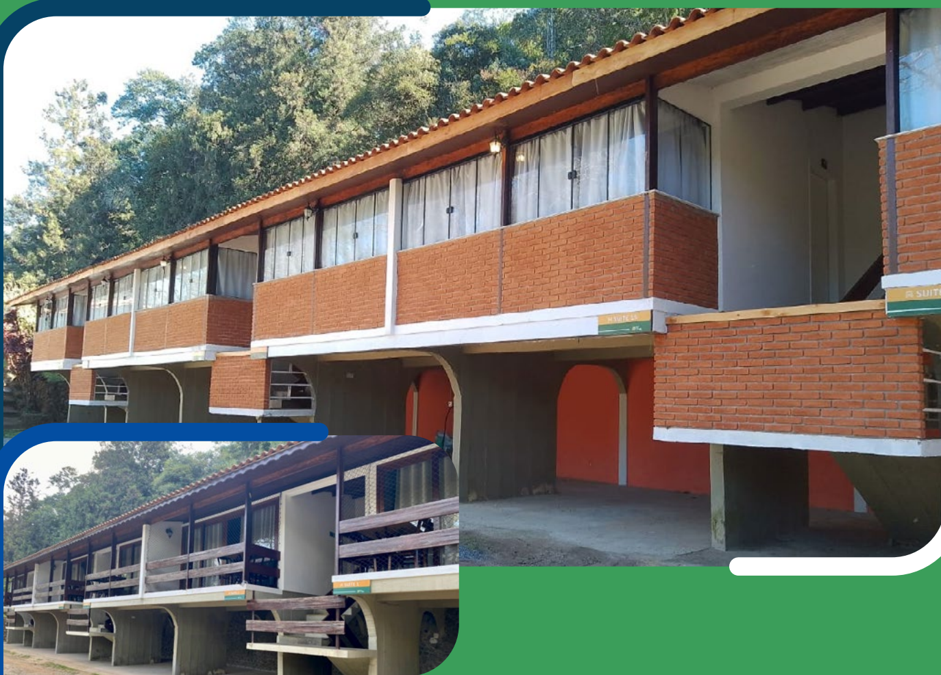
Antes e Depois das instalações reformadas do Hotel Fazenda
